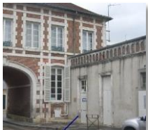
Le Passage Soufflot à Auxerre
